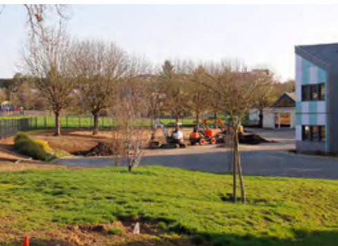
La cour de l'école H. Boucher durant les travaux.
